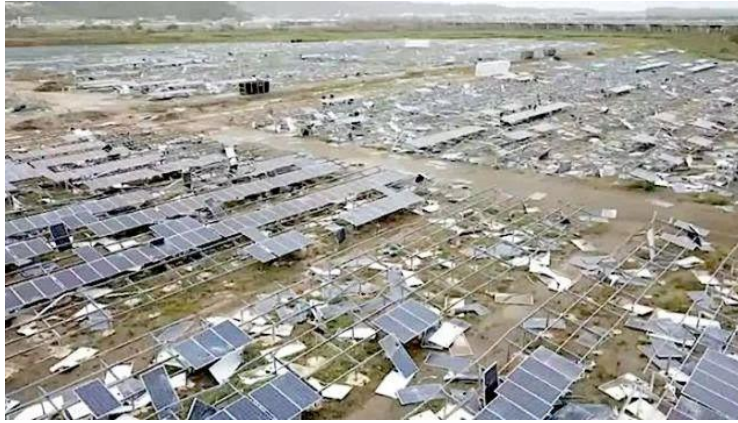
Figure 9. Panneaux solaires endommagés par l'ouragan à Porto Rico. Source.
